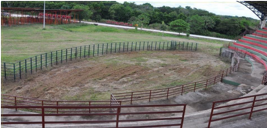
Figura 2. Complejo ferial obra inconclusa
