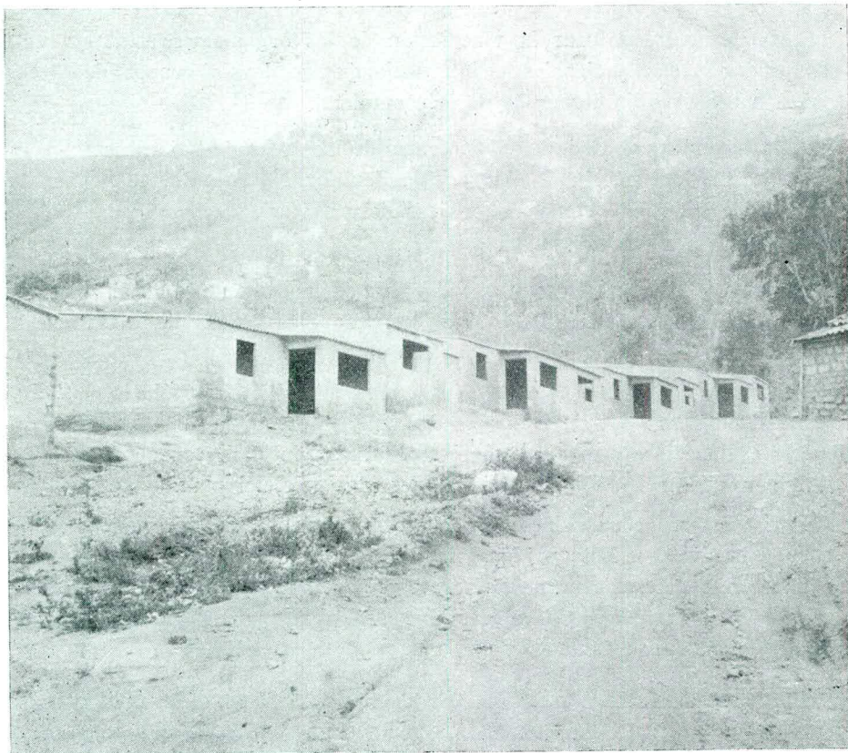
SECTOR REHABILITADO EN LA MISMA ZONA.
