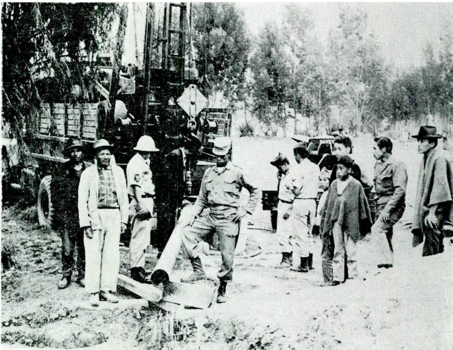
ASPECTO DE LA PERFORACION DE UN POZO PROFUNDO EN LA VEREDA SAN JOSE MUNICIPIO DE BOSA (CUNDINAMARCA).
