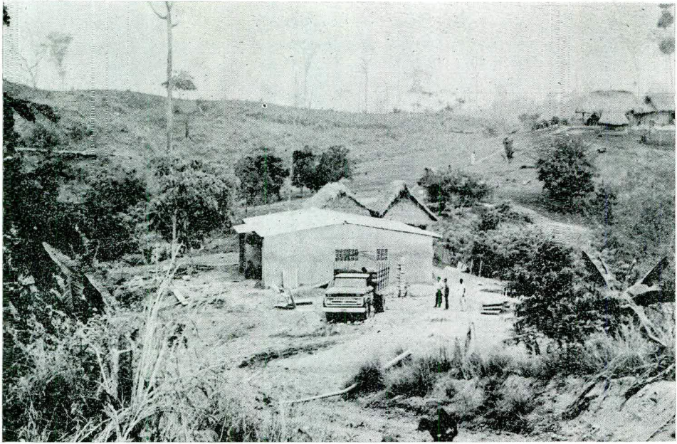
CONSTRUCCION ESCUELA EN LA VEREDA "VIZCAINA ALTA" EN EL MUNICIPIO DE BARRANCABERMEJA (S. S.).
