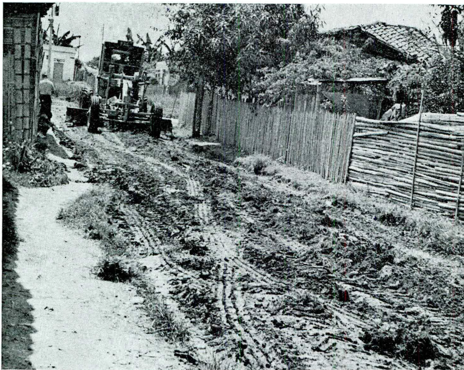
ARREGLO DE CALLES EN EL BARRIO ALFONSO LOPEZ EN CALI, REALIZADO POR PERSONAL DE LA ESCUELA MILITAR DE AVIACION "MARCO FIDEL SUAREZ".
